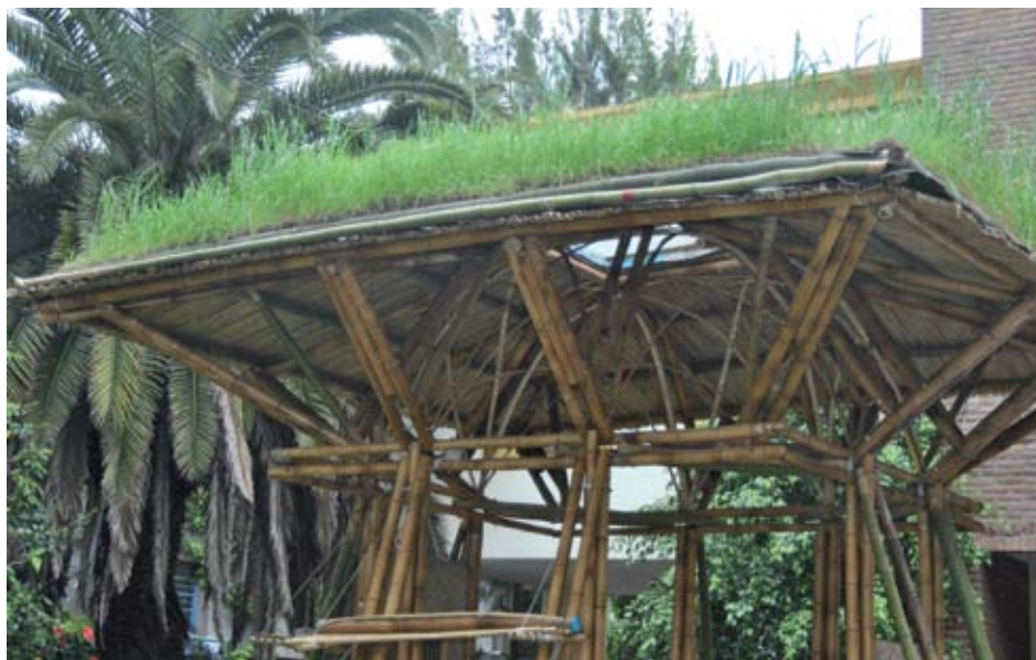
Prototipo construido con Pb. aurea en dependencias de la DPDI.
