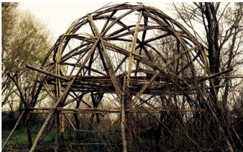
Construcción anónima hecha en bambú en Los Bajos del Temor.
