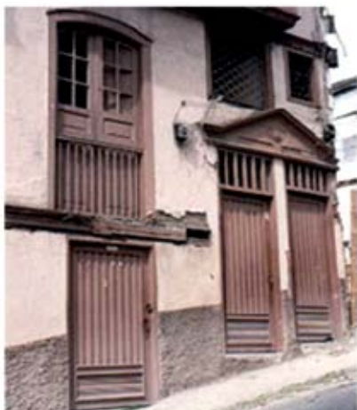
Construcción típica de bahareque en Caldas, Colombia
