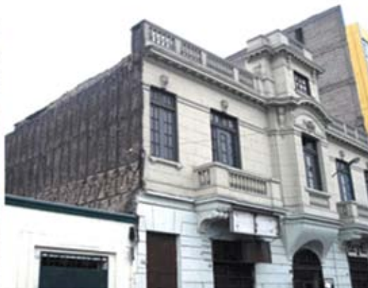
Construcción típica en quincha en Lima, Perú. Fuente: www.probambu.com.ar .
