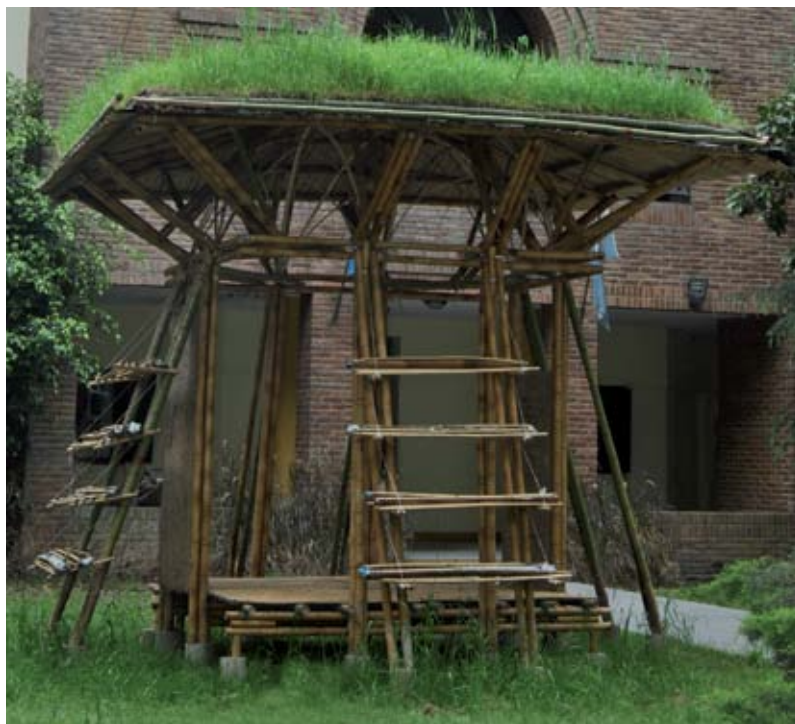
Prototipo construido con Ph. aurea en dependencias de la DPDI.
