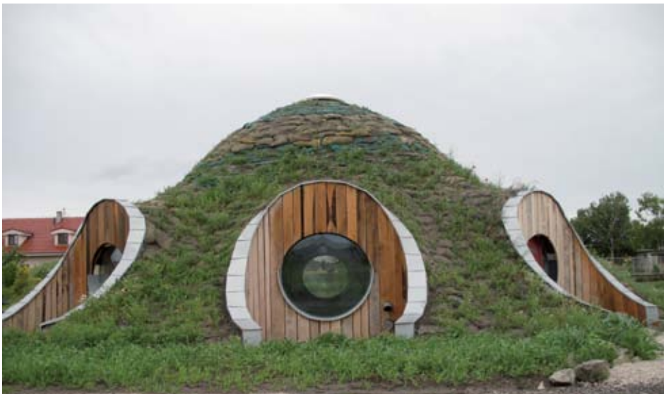
Oficinas construidas con fardos de paja y techo verde por Gernot Minke, Eslovaquia. Fuente: Michelena 2013.
