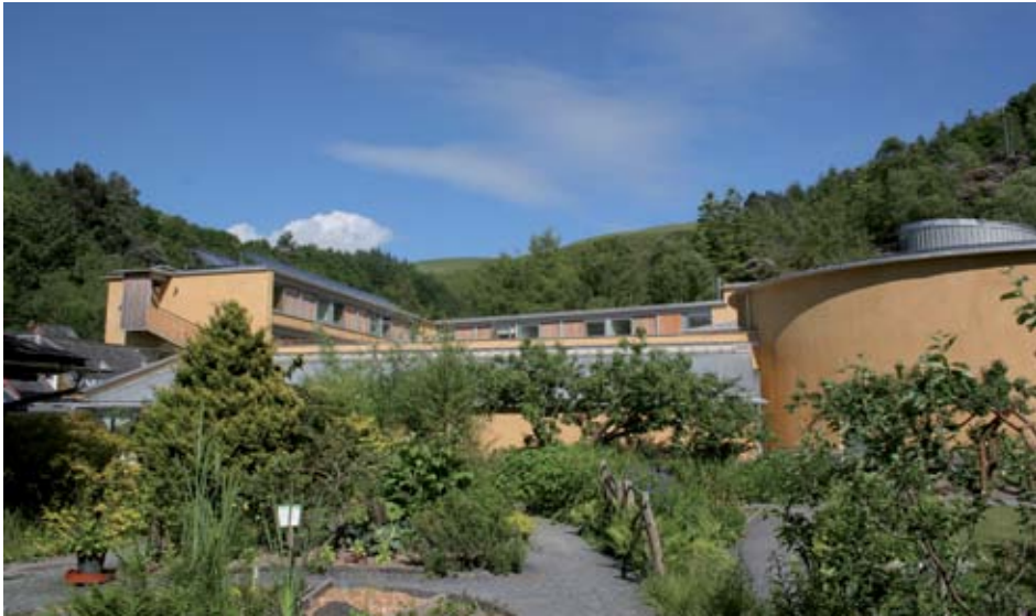
Edificio Wise, CAT Center, Gales. Arquitectos Pat Borer y David Lea. El edificio fue construido con muros de madera rellenos con un compuesto de cáñamo y cal, y con algunos muros hechos con tierra cruda. Fuente: Boco 2013.
