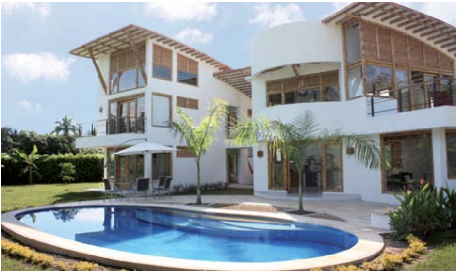
Viviendas realizadas con estructura y cerramientos íntegramente en bambú por la arquitecta Carolina Zuluaga, Colombia. Fuente: zuarq.blogspot.com.
