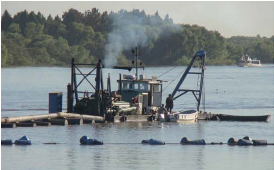
Trabajos de dragado en el Canal Vinculación.
