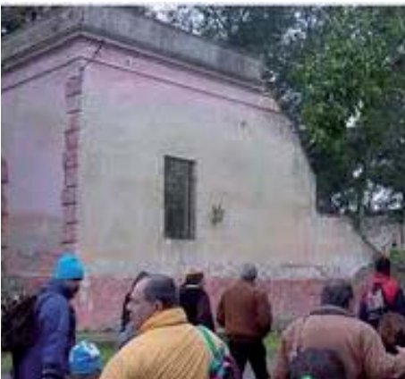
La fachada que queda del antiguo Cuartel.
