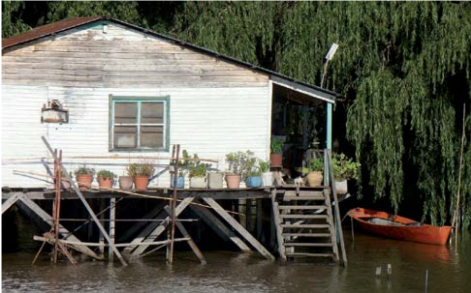
Construcción elevada, atenta a los picos de marea.
